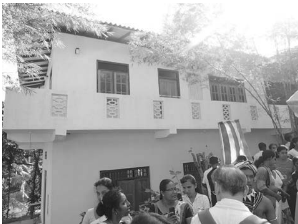
新設された図書室 2階部分
